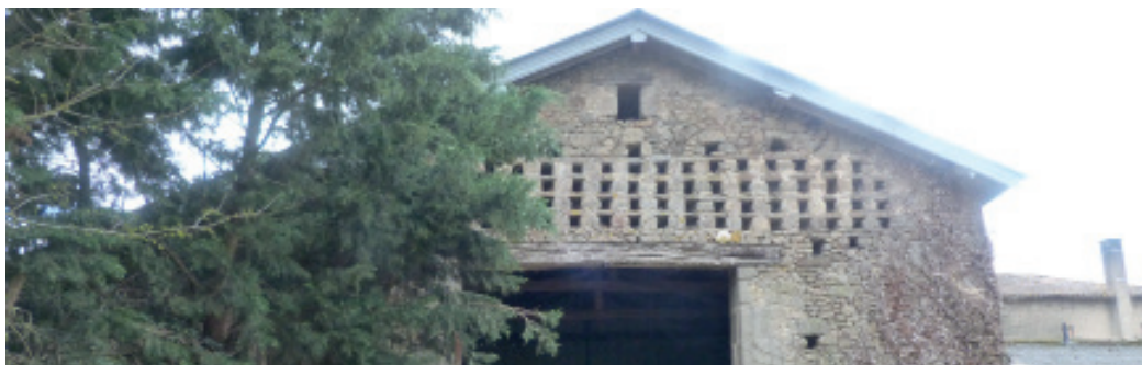
Vue des trous de boulin de la grange, ferme de Beaumont
