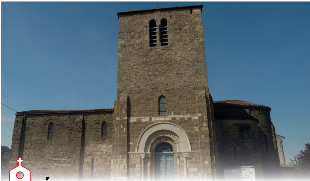
Vue de l'église et du clocher après restauration
